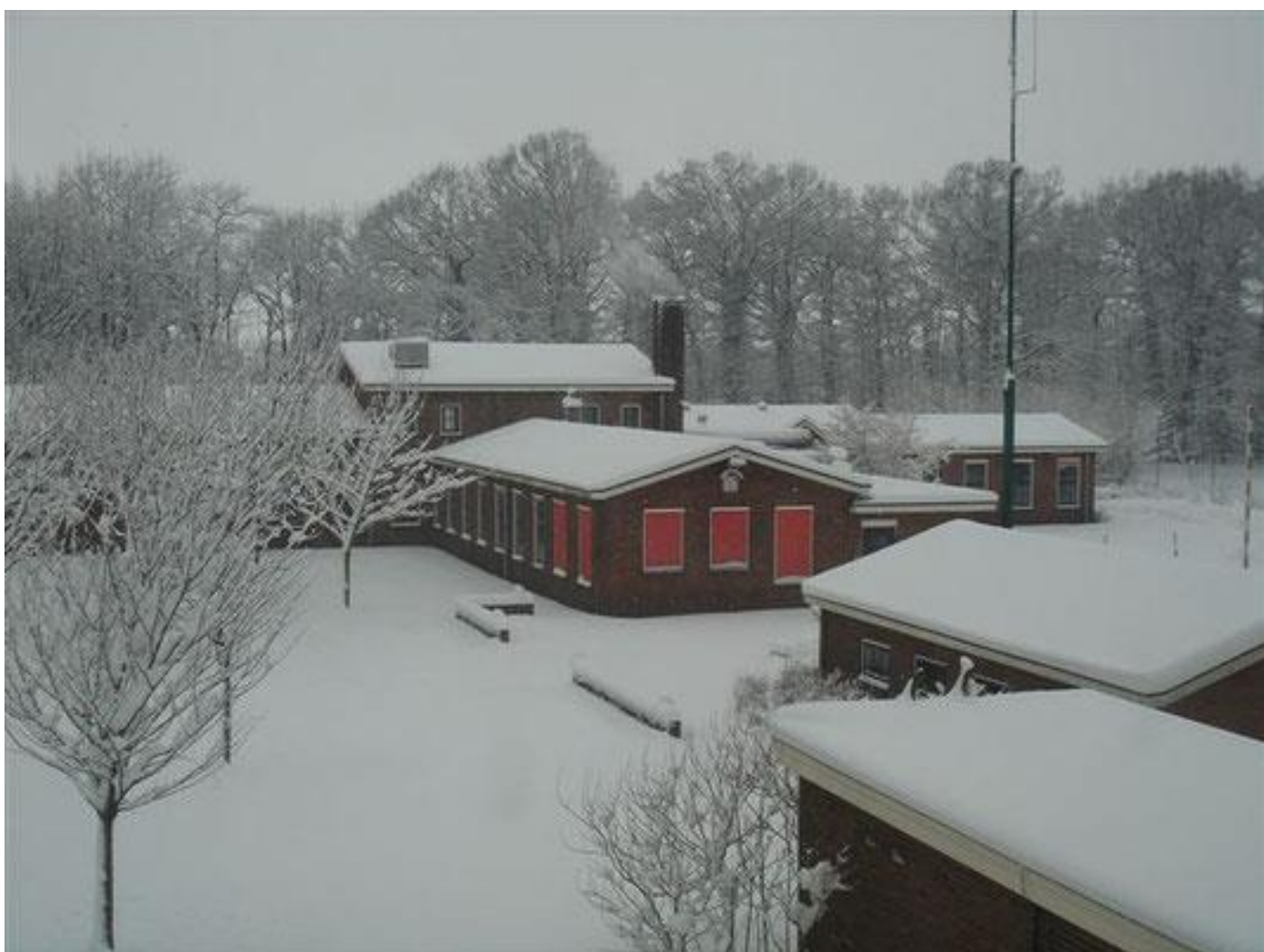
Gewa kazerne opleidingsinstituut Veenhuizen
